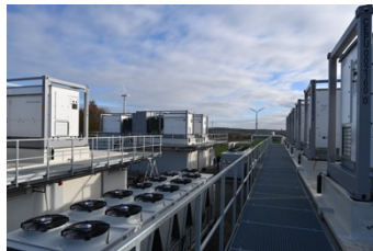
2022 stellte ju:niz Energy in Eisenach (Thüringen) einen der größten Batteriespeicher in Europa fertig. SMAREG4 verfügt über eine Gesamtkapazität von 67 MWh und eine Leistung von 60 MW. Der Speicher wird hauptsächlich für PRL (Primärregelleistung) und VNE (vermiedene Netzentgelte) eingesetzt.
