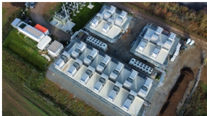
2022 stellte ju:niz Energy in Eisenach (Thüringen) einen der größten Batteriespeicher in Europa fertig. SMAREG4 verfügt über eine Gesamtkapazität von 67 MWh und eine Leistung von 60 MW. Der Speicher wird hauptsächlich für PRL (Primärregelleistung) und VNE (vermiedene Netzentgelte) eingesetzt.
